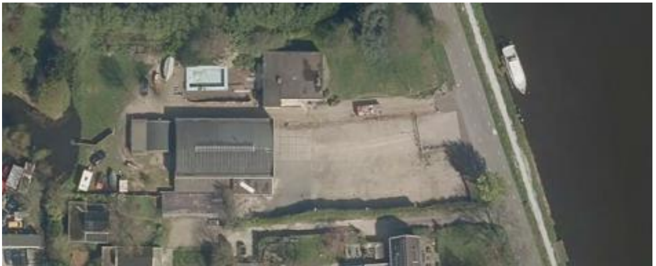
Luchtfoto Amsteldijk-Noord 100 en 100a
