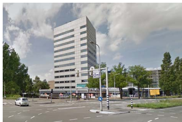
Figuur 1.1b: Huidige bebouwing
