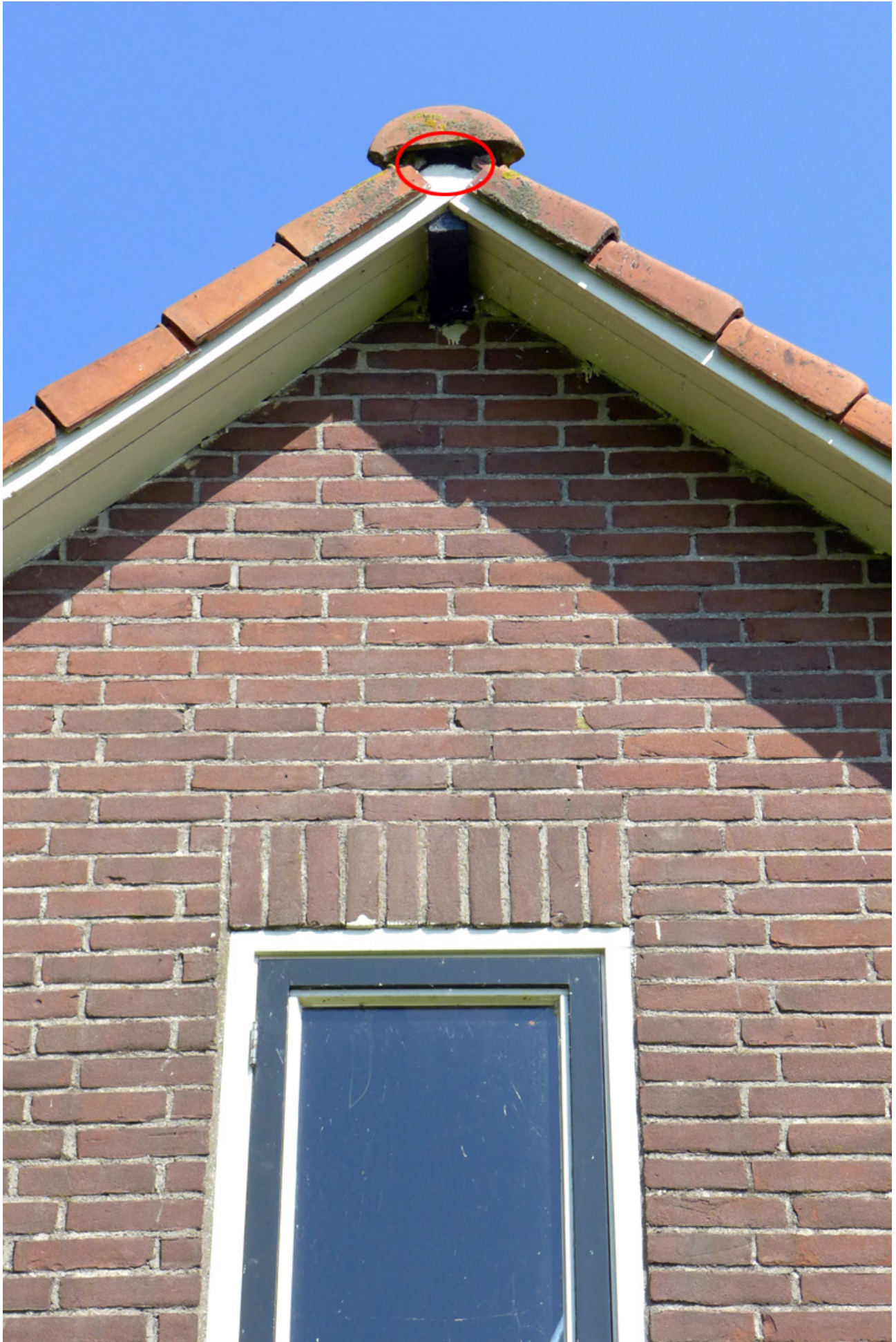
Afb.5: Gat onder de noksteen waar vleermuizen onder beide zijden van het dak kunnen komen. Daarmee toegang tot verschillende microklimaten
