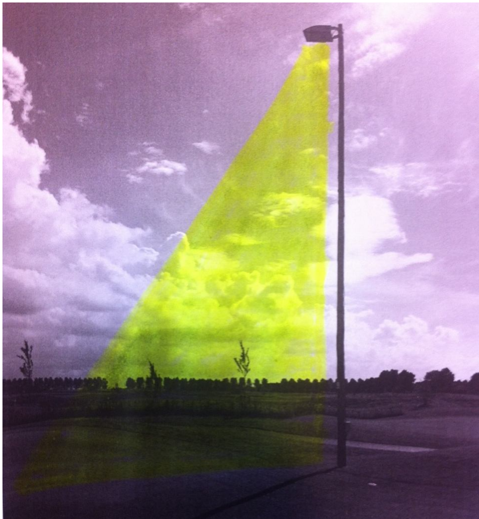
Naar beneden gericht armatuur met de naar beneden gerichte lichtbundel
