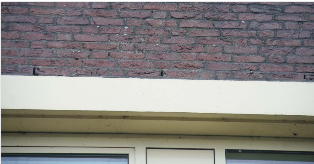
Spouwgaten in de muren geven mogelijk toegang tot voor vleermuizen beschikbare holtes.
