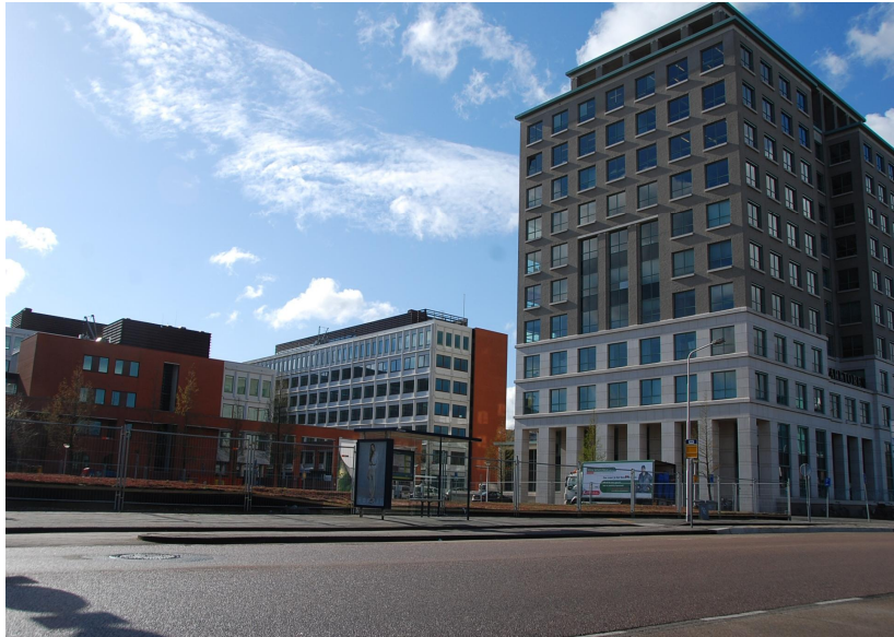
Het kantoorgebouw ten zuiden van het plangebied
