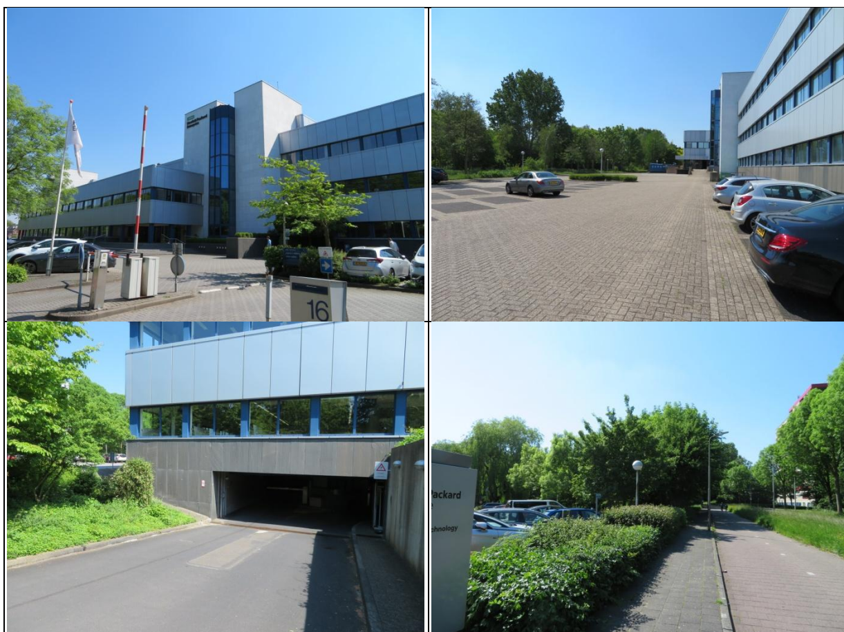
Foto's 1 t/m 4 – het noorden van het terrein met voorgevel van het gebouw, de zuidzijde van het terrein met parkeerplaatsen, de ingang van de parkeergarage en bosschages in het westen van het plangebied.
