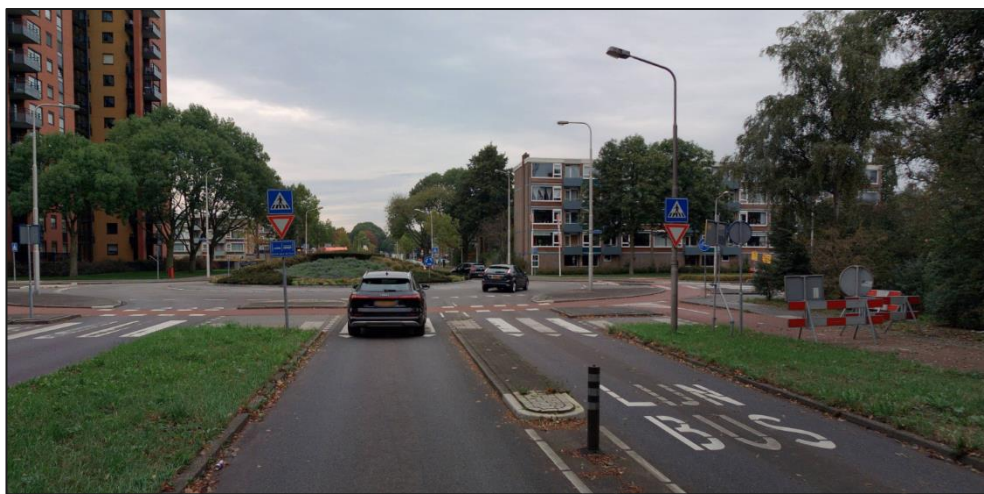
Figuur 4: Aparte rijstrook voor lijnbus op rotonde Van der Hooplaan - Sportlaan
