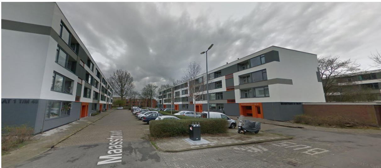
Huidige situatie parkeergebied tussen woonblokken Maasstraat (bron: Google Street View)
