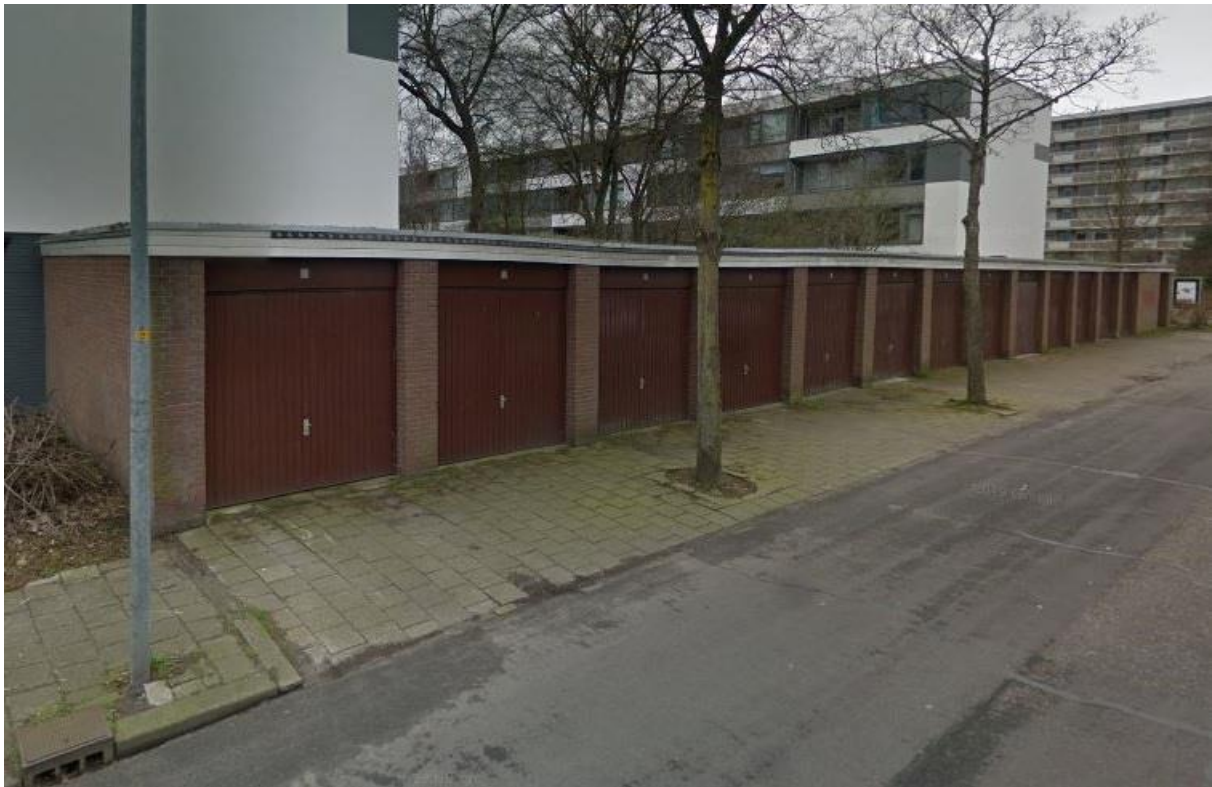
Huidige situatie garageboxen (bron: Google Street View)
