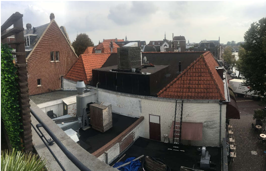
Afbeelding 2.6: Bestaande kapconstructie hoofdgebouw en tussenlid
