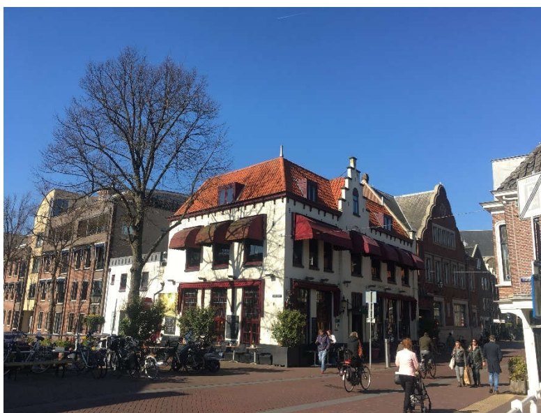
Afbeelding 2.1: Aanzicht huidige situatie Koorstraat 30
