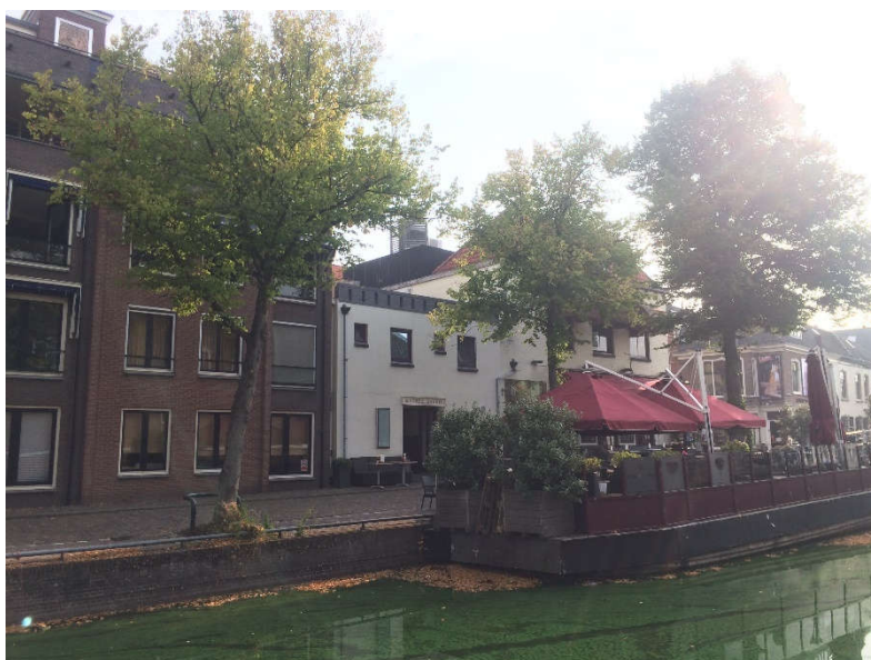
Afbeelding 2.2: Aanzicht huidige situatie Lindegracht 69 (tussenlid)
