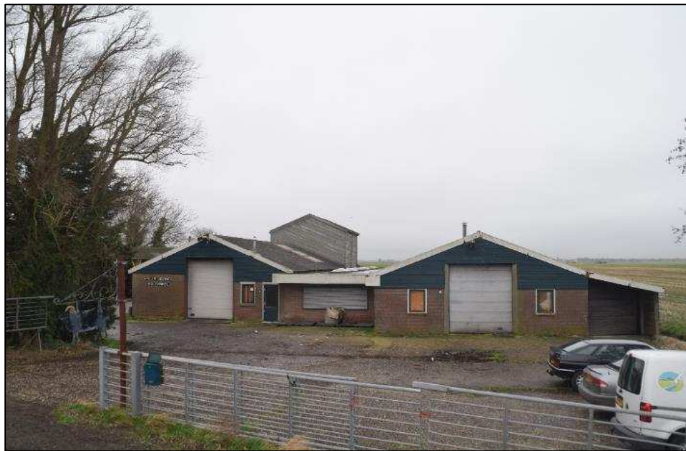
loodsen in het plangebied.
