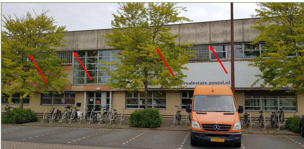
Figuur 5 Nestlocaties 1, 2, 3 en 4 aan de voorzijde van het pand.
