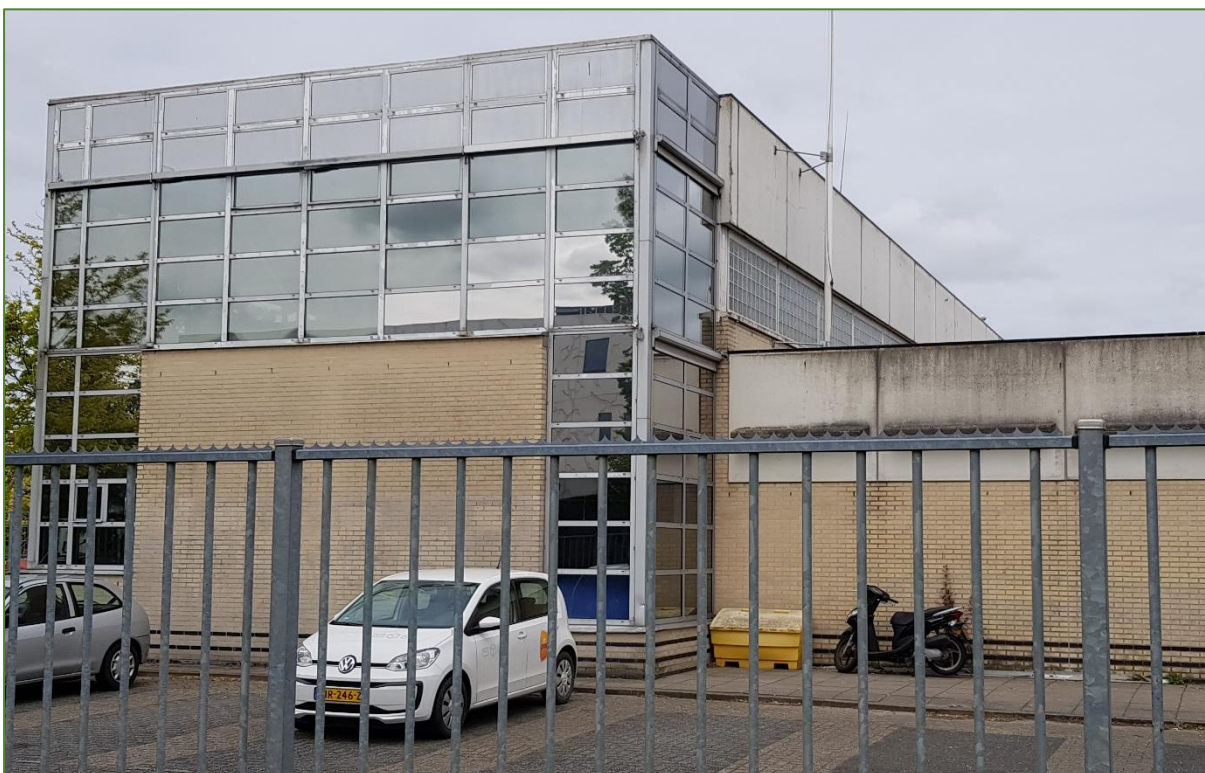
Figuur 7 Nestlocatie 6 aan de achterzijde van het pand.
