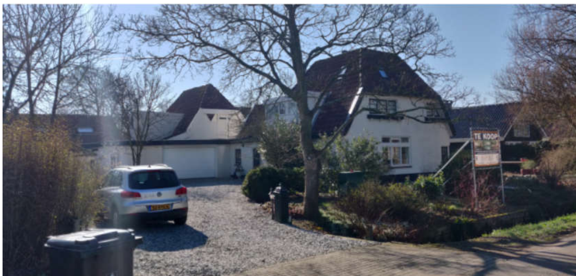
Figuur 2.1: Foto bestaande situatie
