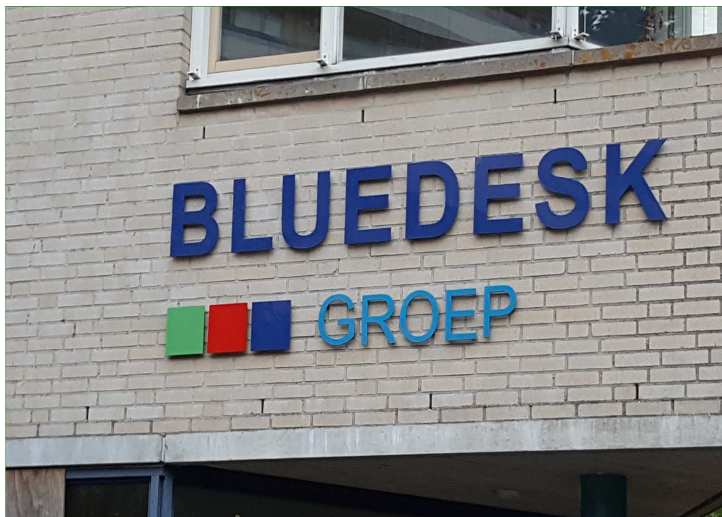
Stootvoegen in de muren kunnen toegang geven tot voor vleermuizen geschikte holtes..
