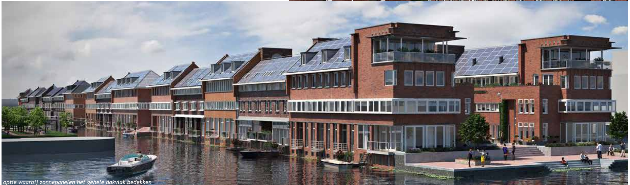
optie waarbij zonnepanelen het gehele dakvlak bedekken
