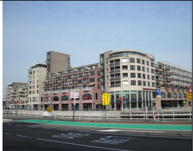
Ten zuidwesten van de molen bevindt zich het winkelcentrum Noorder Arcade. De forse bouwvolumes zullen de overheersende luchtstroom doen stijgen bij zuidwesten wind. Gelukkig is de afstand tussen deze gebouwen en de molen behoorlijk groot, namelijk minimaal 380 meter.
