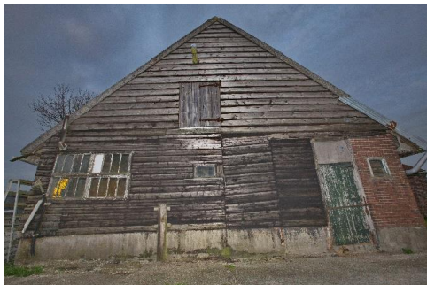
Figuur 5A: achterzijde paardenstal
