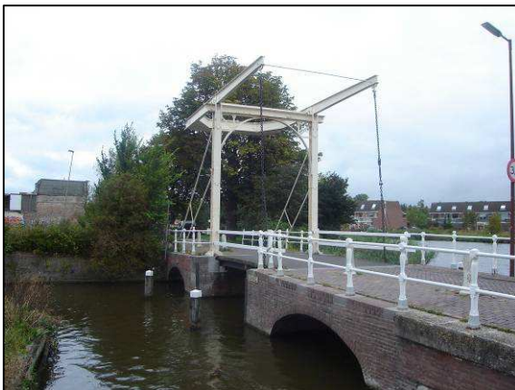
Afbeelding: de Boompoortbrug
