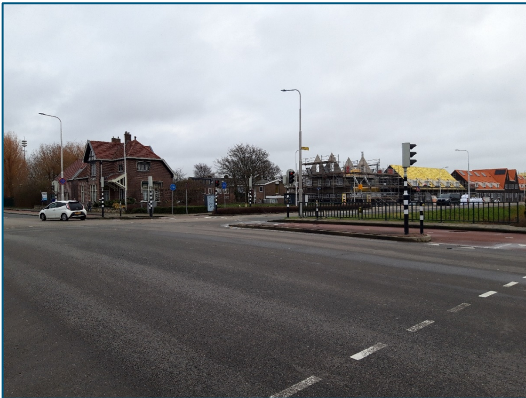
Figuur 2-2. Kruising Aalsmeerderweg met de Machineweg. Foto: RHDHV, 2021.
