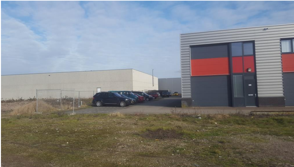
Figuur 6: Het huidige terrein, daar waar het zich L-vormig verbreedt aan de achterzijde van het naastgelegen bedrijfsverzamelgebouw (rechts) en grote hal (links), gezien -> N. Dit is de “knik van de L” van het voorste deel, met gedeeltelijke omheining.
