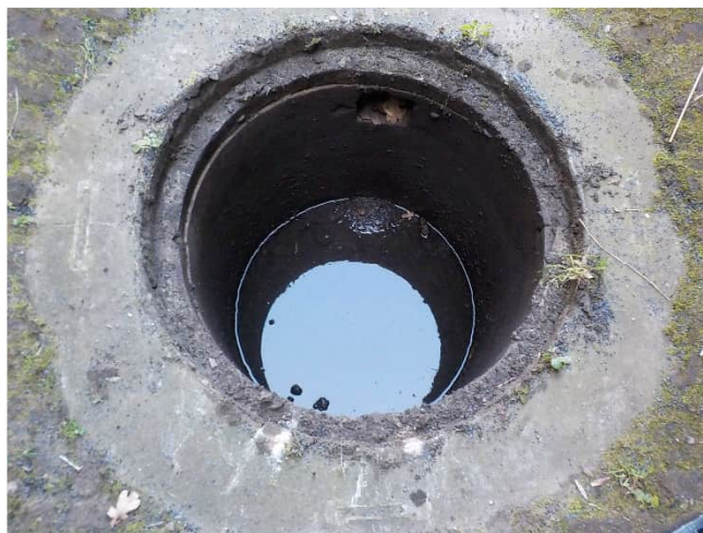
Foto 14 (inhoud bezinkput vuilwaterriolering)
