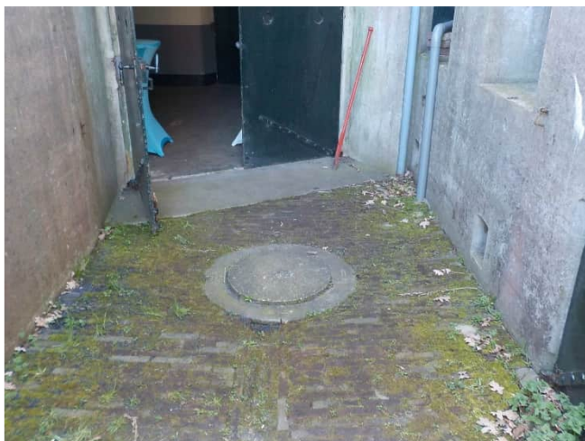
Foto 13 (bezinkput vuilwaterriolering)
