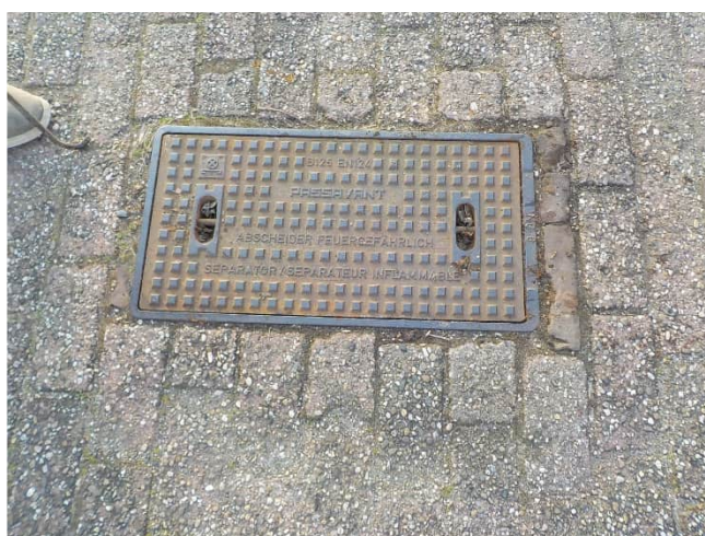
Foto 12 (detail olie/waterafscheider nabij afspuitplaats)
