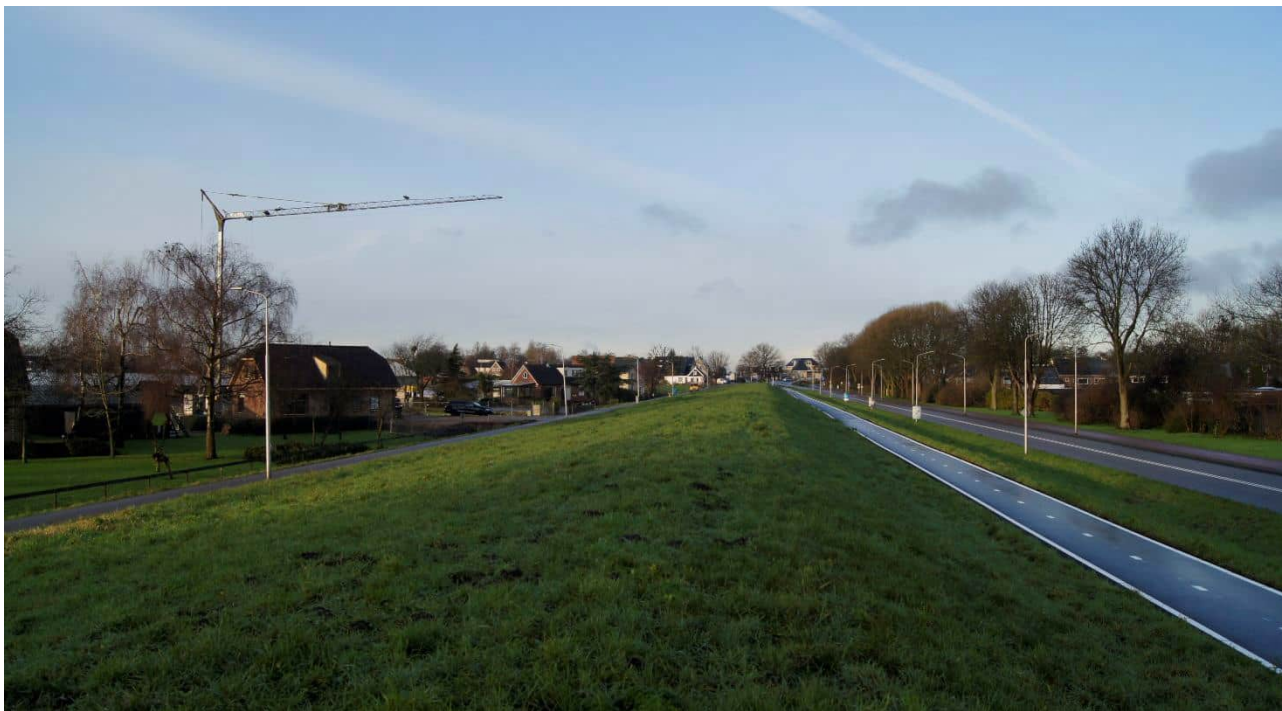
Figuur 8. De liniedijk met fietspad (hoofdverdedigingslijn)
