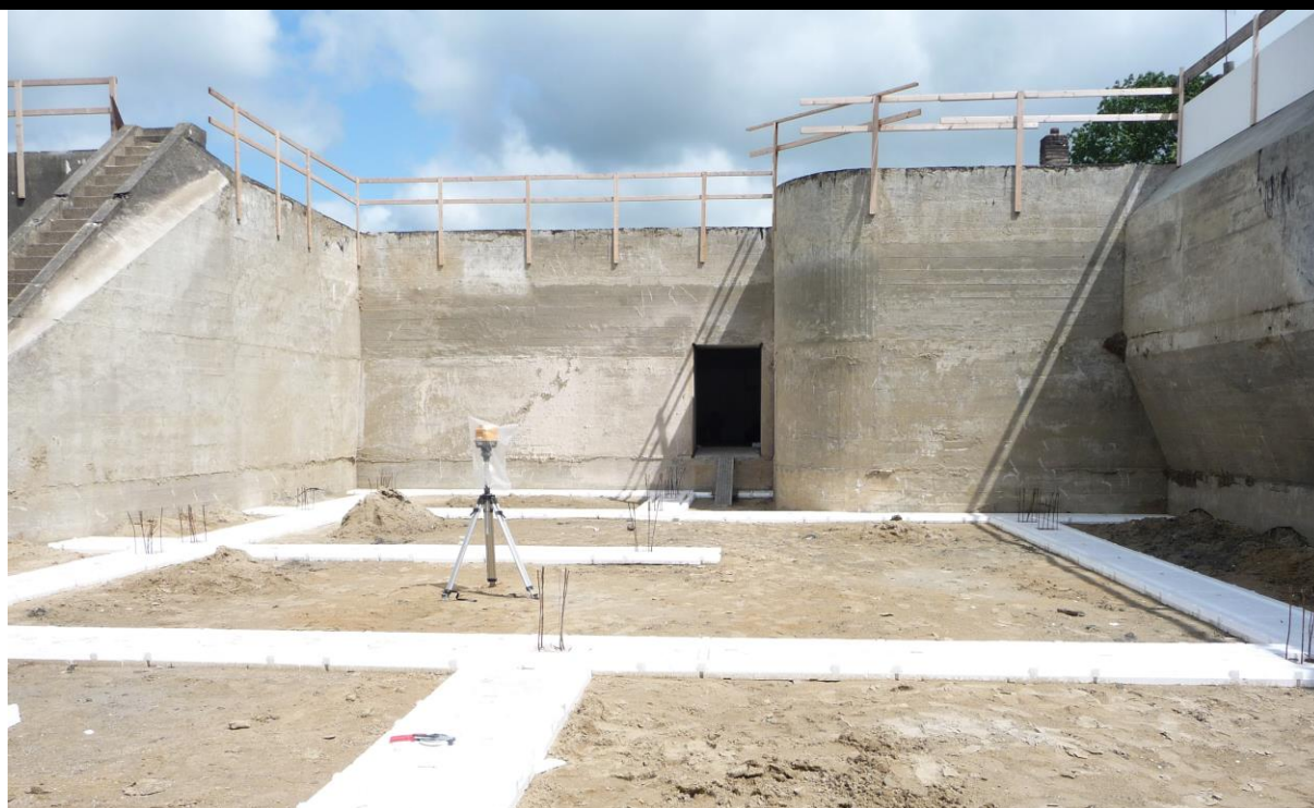
Bouw rondom fort met ontgraving langs muur
