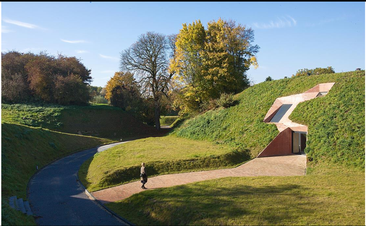
Voorbeeld van in- en uitgang uit kazematten of dijklichaam
