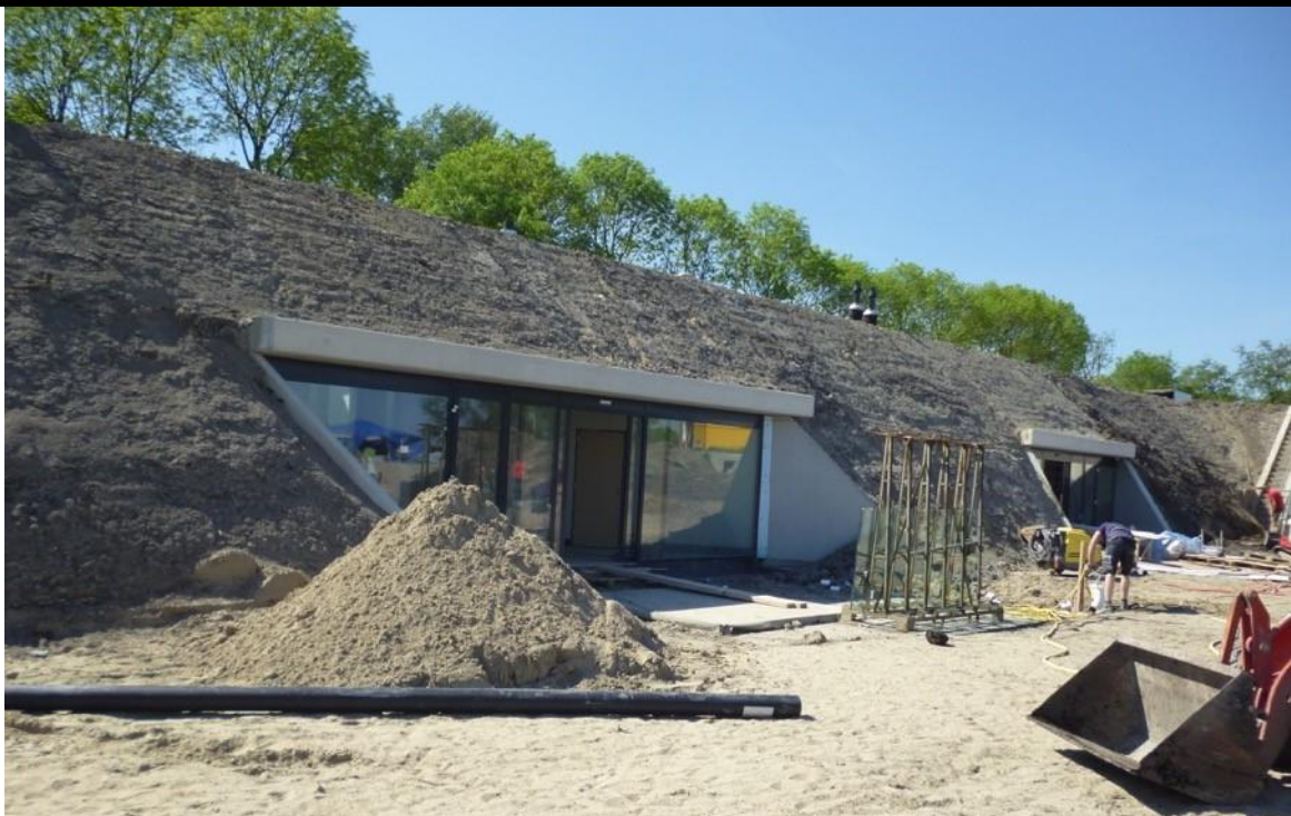
Bouw in een dijklichaam met nabootsing van originele elementen
