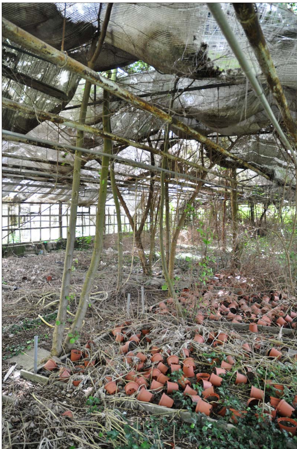
Afbeelding 22. Foto van de kas waarbinnen boring 9 en 10 zijn gezet. De foto is richting het zuidoosten genomen.
