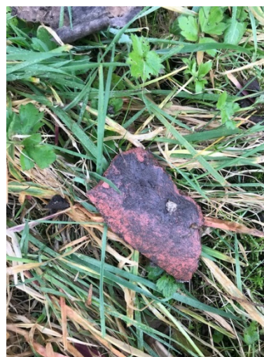
Rode asbest golfplaat RE1
