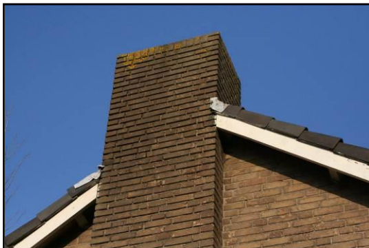
Foto 10: Stenen schoorsteen op de woning met loodflappen
