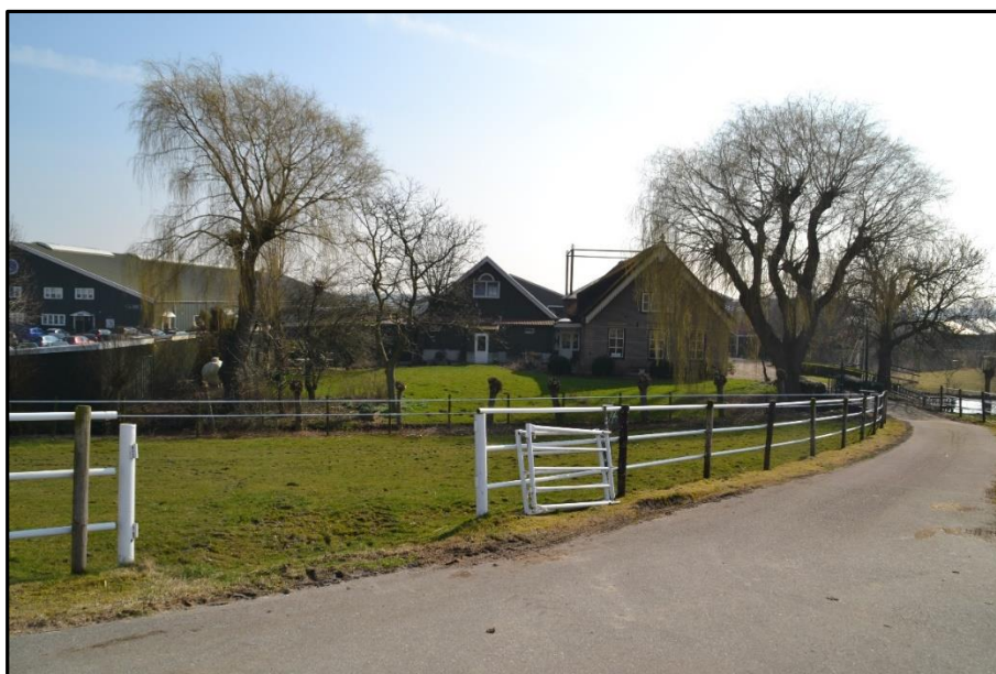
Afbeelding 8: De entree met het groene voorerf van de oude boerderij. Het witte hekwerk trekt aandacht van het aanzicht van de boerderij.
