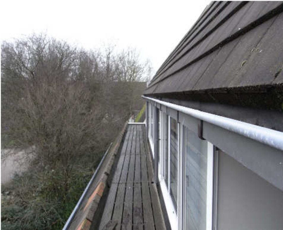
Foto 14 Dak westelijke bebouwing
