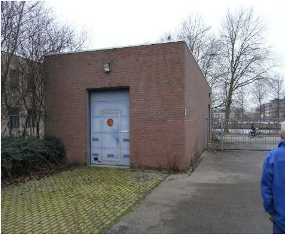
Foto 9 Energiegebouw aan noordzijde projectgebied
