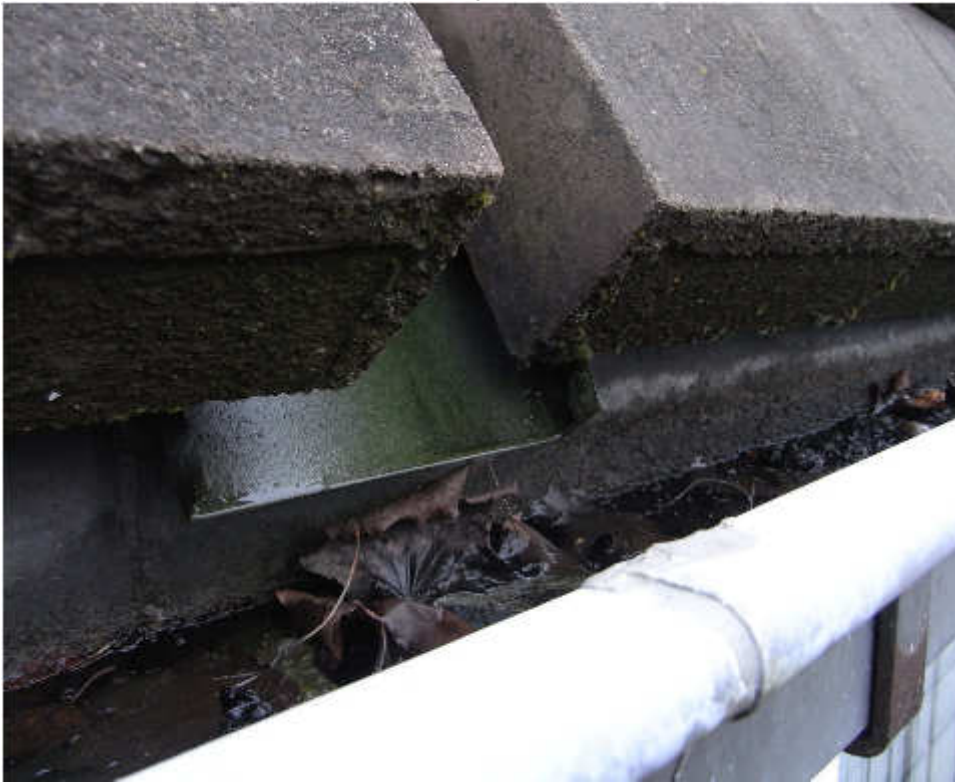
Foto 15 Detail dak westelijke bebouwing (zie foto 14)
