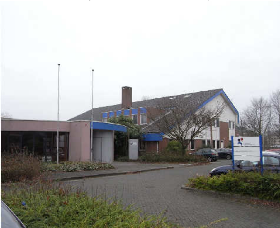
Foto 10 Zuidzijde projectgebied vanuit zuidwestelijke richting
