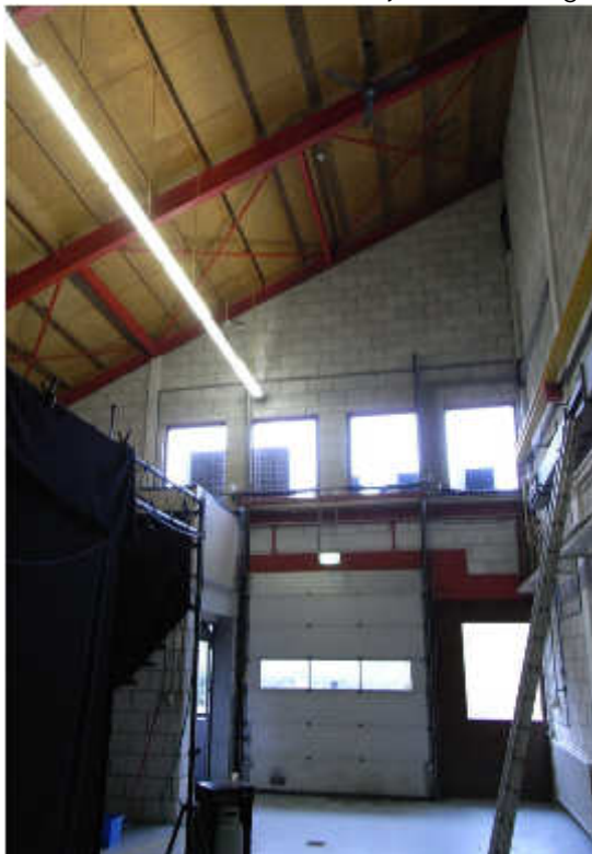
Foto 19 Loods in noordoostelijke bebouwing
