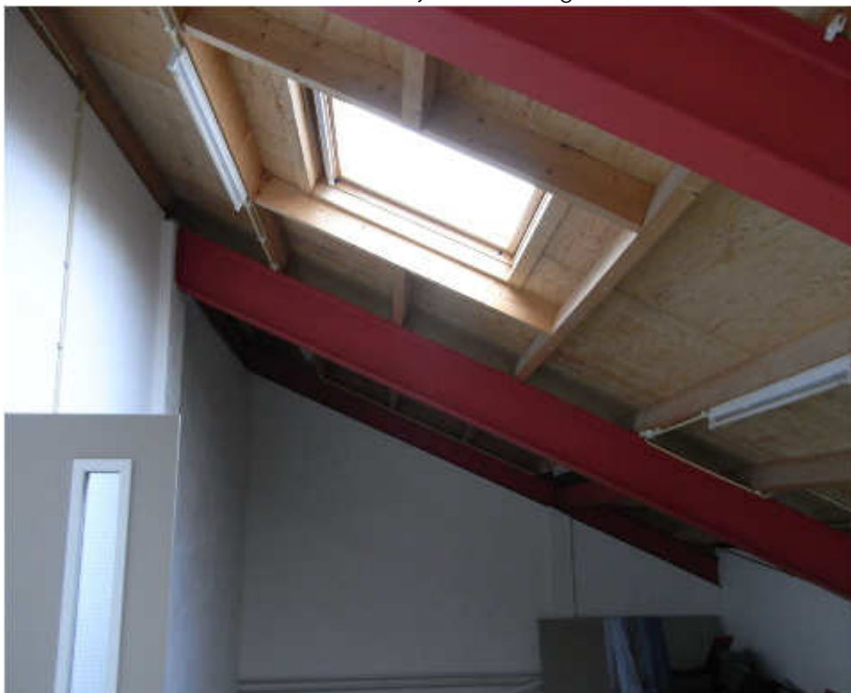
Foto 18 Ruimte onder het dak in oostelijke bebouwing
