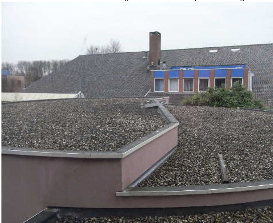
Foto 11 Plat dak centrale bebouwing met zicht op oostelijke bebouwing
