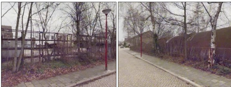
Situatie voor de sloop van de bedrijfsbebouwing
