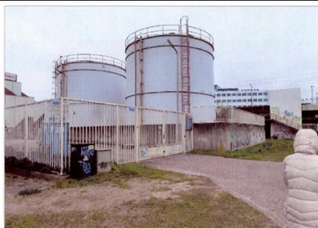
Afbeelding 3 - twee tanks voor de opslag van gasolie naast parkeerplek P15
