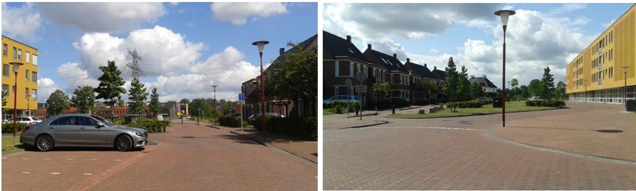
Asverspringing in de Middelhoeve (Het Eiland), fietsers hebben vrij doorgang via een fietsdoorsteekje.
