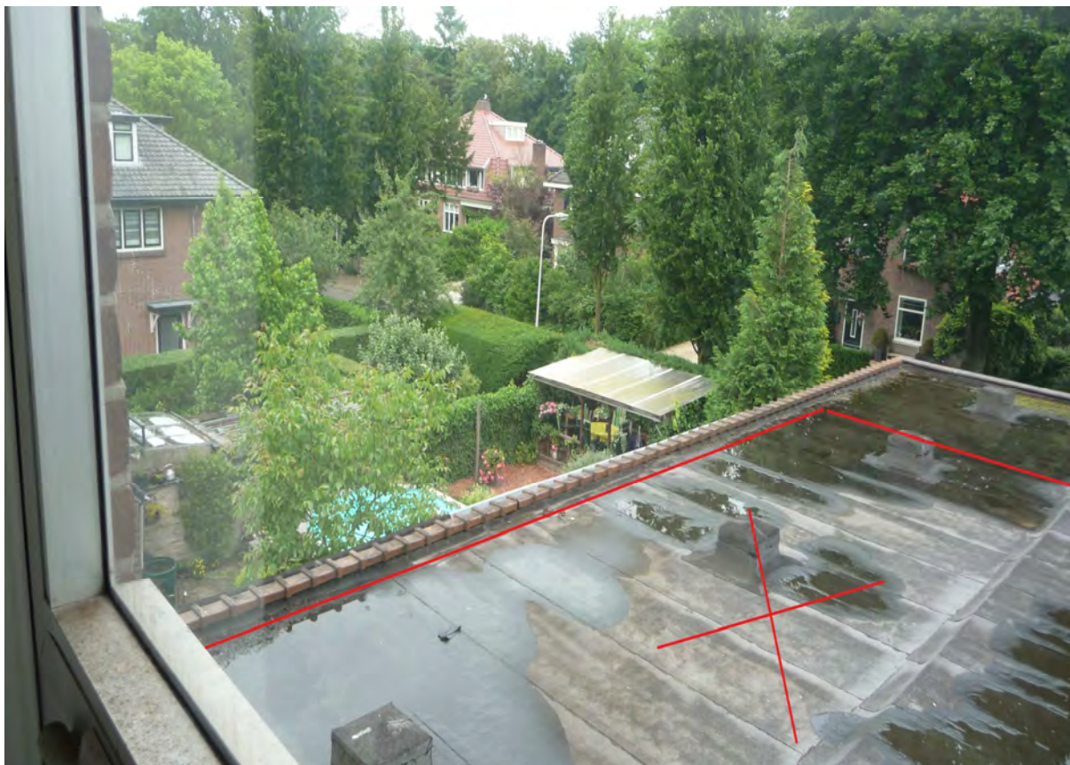
Indicatie van het te verwijderen deel van het dak van de uitbouw (bron: D. Franken)
