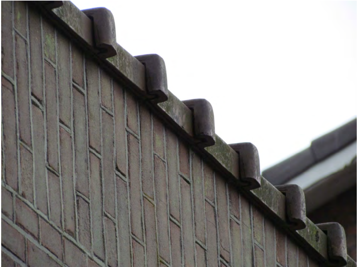
De dakbedekking van de uitbouw is met speciale pannen bevestigd aan de muren (HB)
