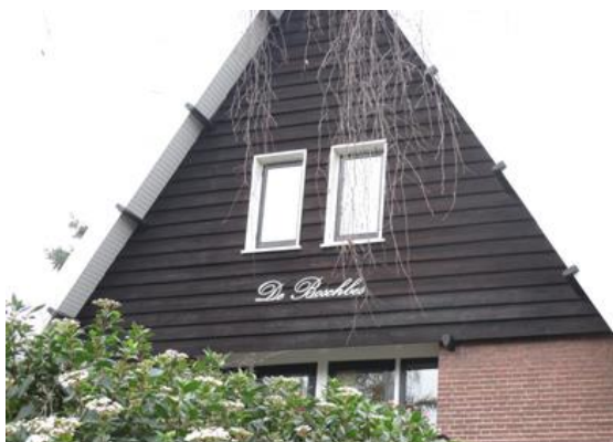
Potdeksel gevelbekleding van een woning aan de Berkenlaan
