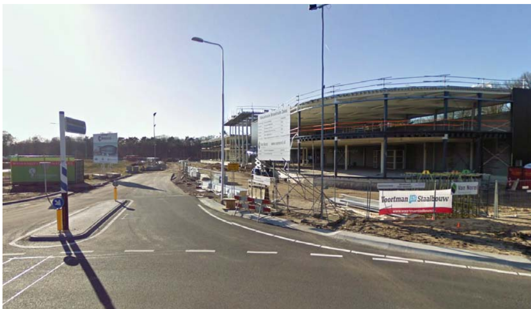
De Autoboulevard toen deze nog in aanbouw was (bron: Google Streetview)
