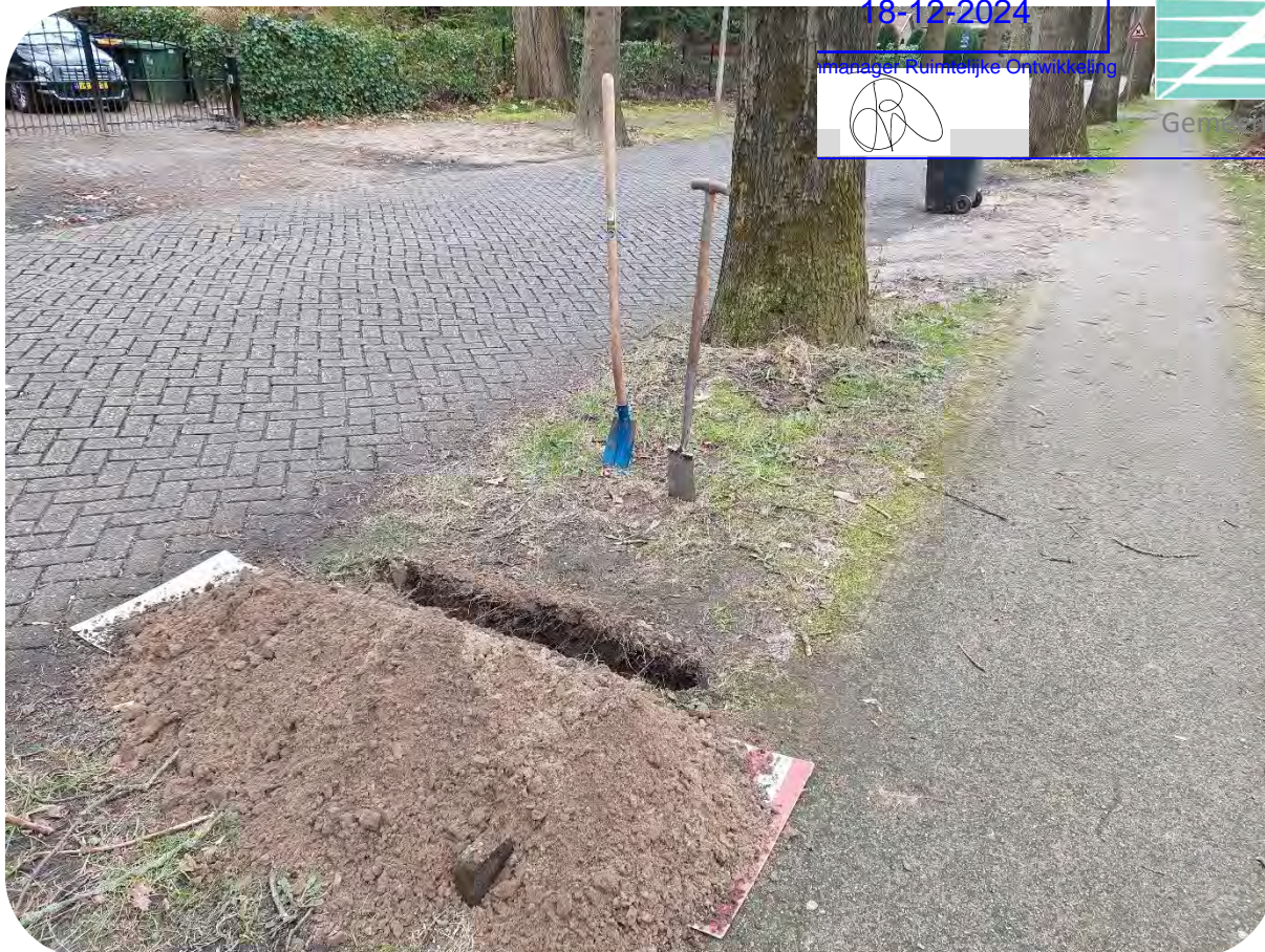
Foto 20: proefsleuf 5, nabij boom nummer 42, op circa 2 meter uit de boom
