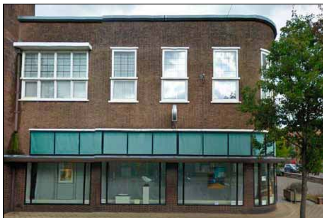
Bestaand gebouw (gemeentelijk monument) aan de Steynlaan (nr. 4), gebaseerd op de Amsterdamse School
