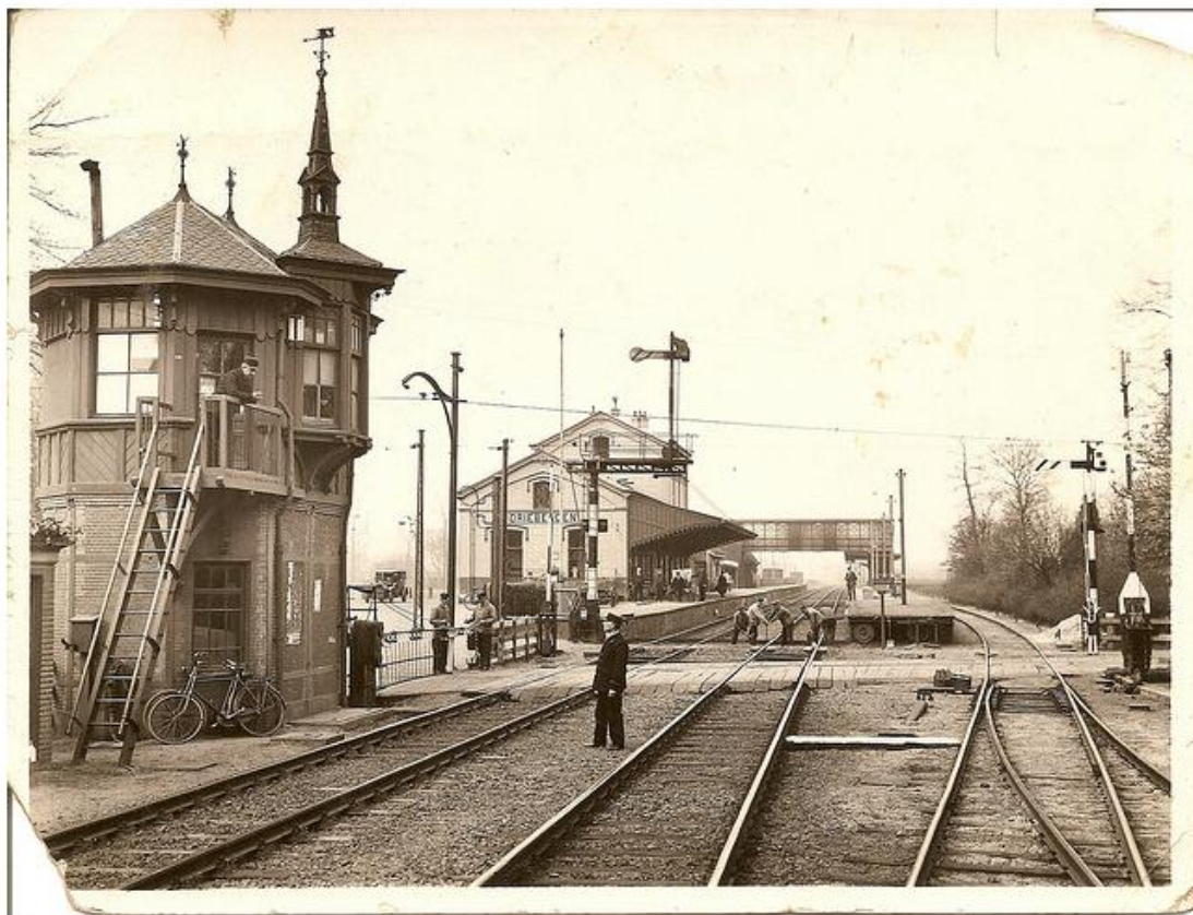
Afbeelding 7 Overwegpost in het “ensemble” van stations voorzieningen bij Driebergen Zeist.
