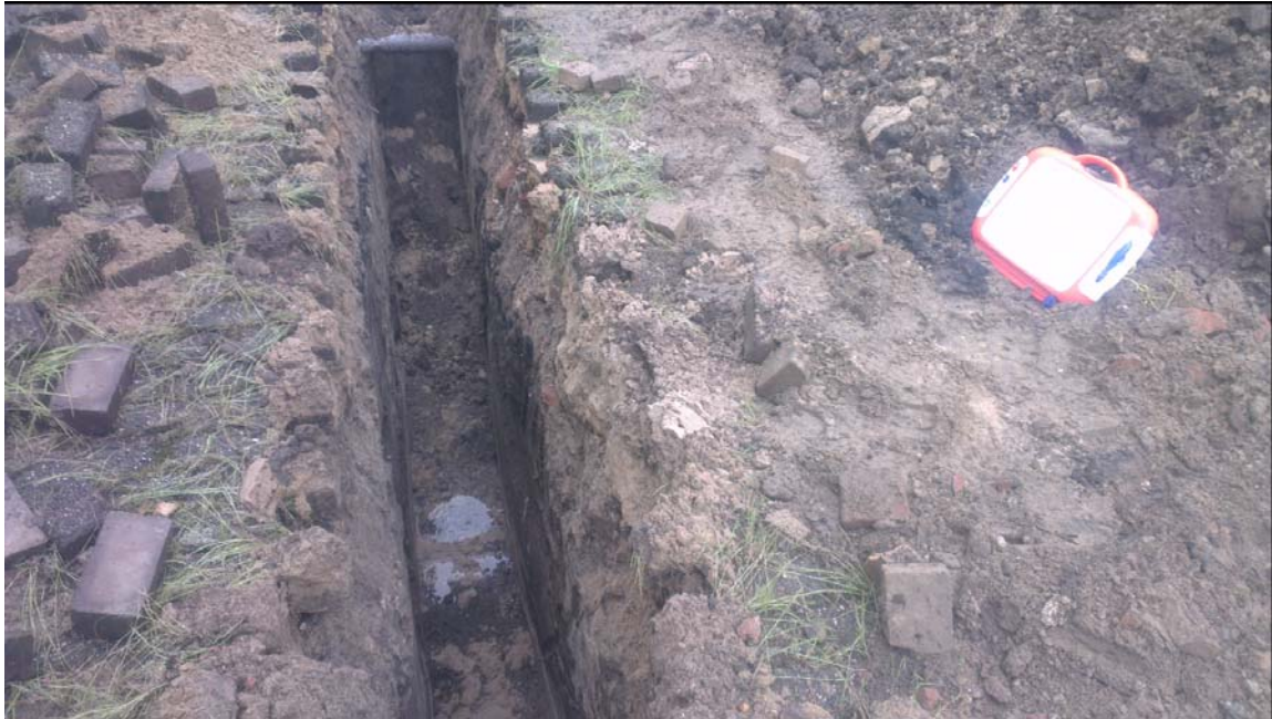
RE 7: Uitpandig Griffensteijnselaan 202: proefsleuf 1 (slootdemping)
