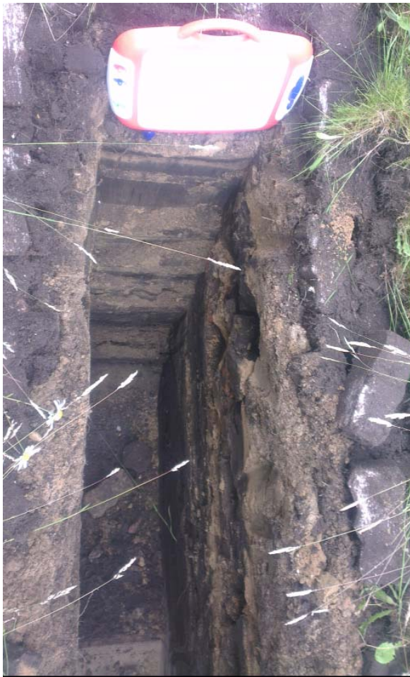
RE 7: Uitpandig Griffensteijnselaan 202: proefgat 2
