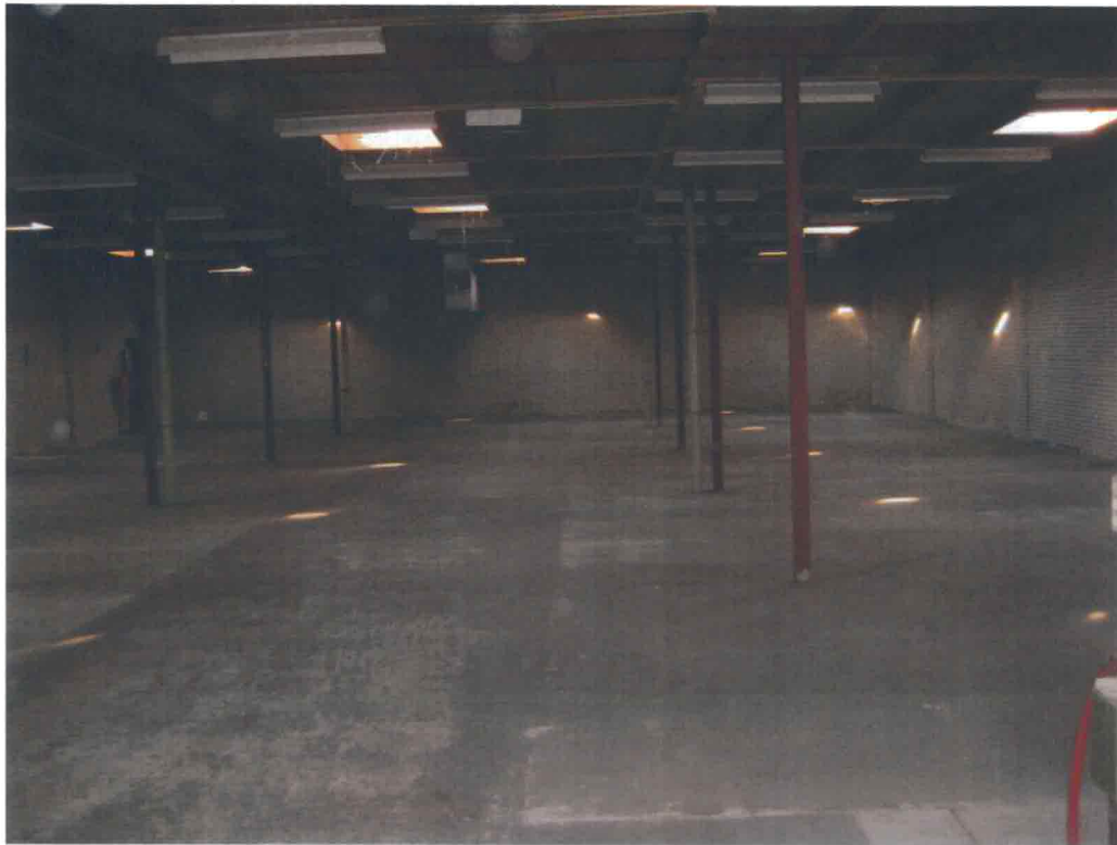
Foto 3: pand achterzijde Koppelweg 11 (leegstaand)
