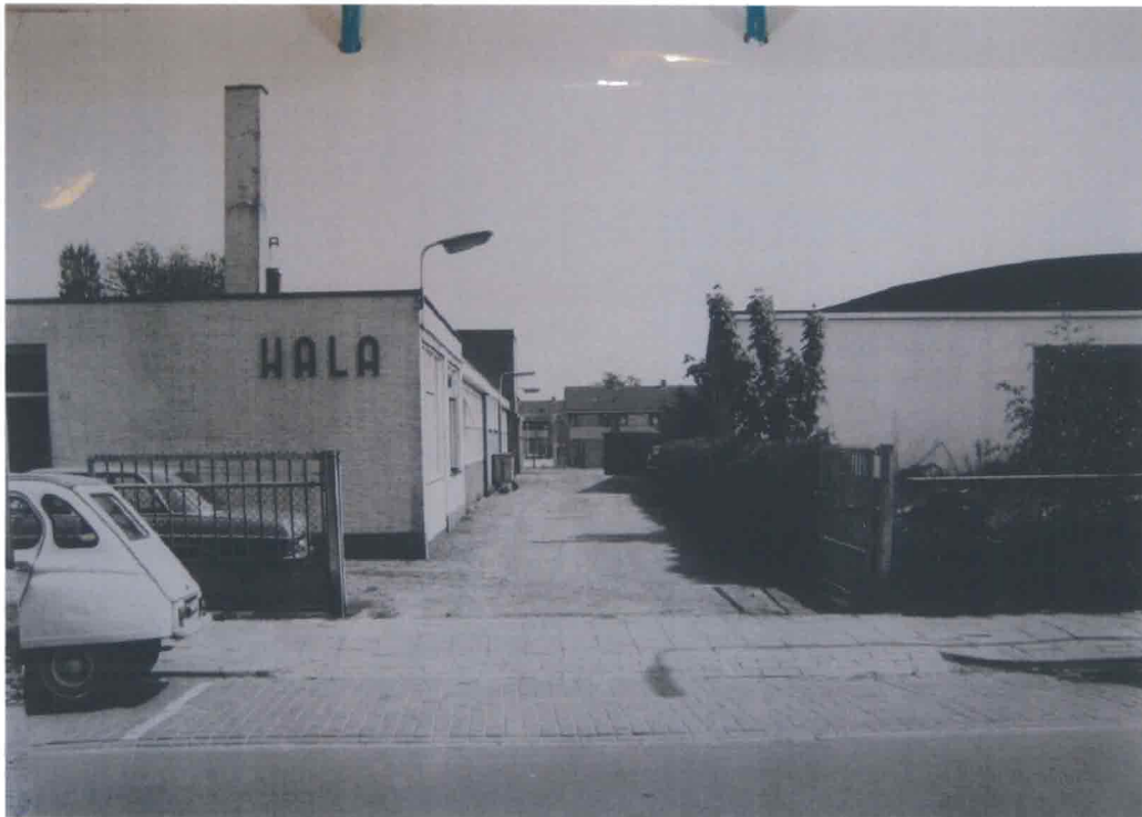
Foto 5: pand Koppelweg 11 (HALA), gezien vanaf de Koppelweg (1970-1975)
