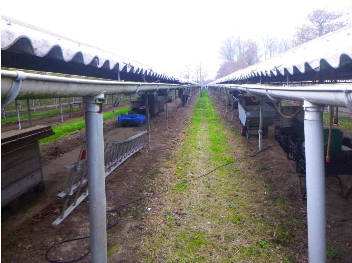
Figuur 17: Het plangebied nabij boorpunt 4, gezien in noordwestelijke richting
