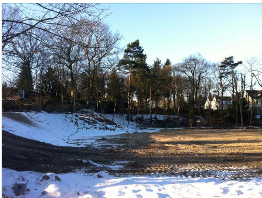
Deltaterrein, na sloop van de gebouwen
