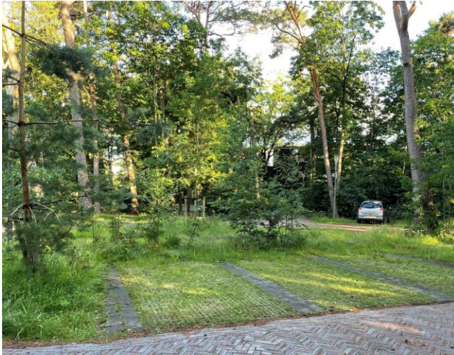
PARKEERPLAATSEN IN GRASBETONSTENEN
