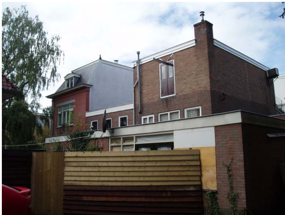
Foto 2-5: Panden 822, 823 en 824 gezien vanaf de projectlocatie.
