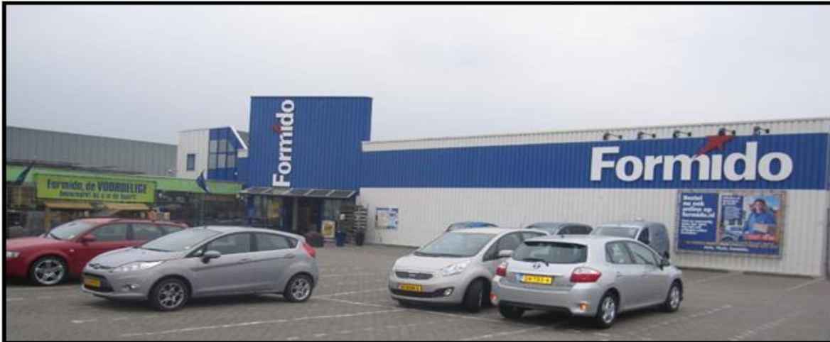
Entree en parkeerterrein huidige situatie
