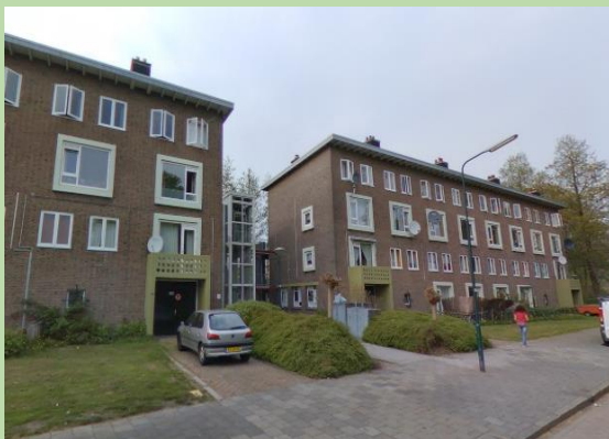
Figuur 3.1 Deelgebied 1: de flats aan de Anna van Buren straat
