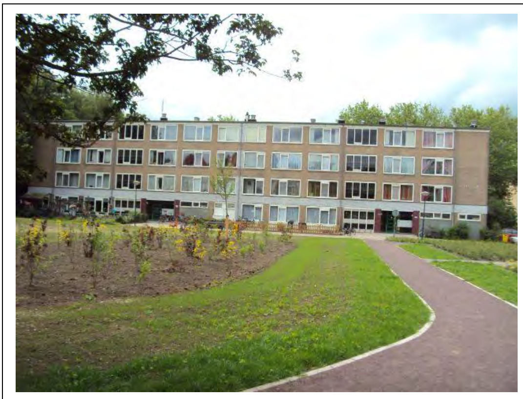
Foto 2. Overzichtsfoto bebouwing locatie 2, Cape Kennedy.
