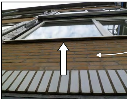
Figuur 3: Invliegopening onder kozijn.
