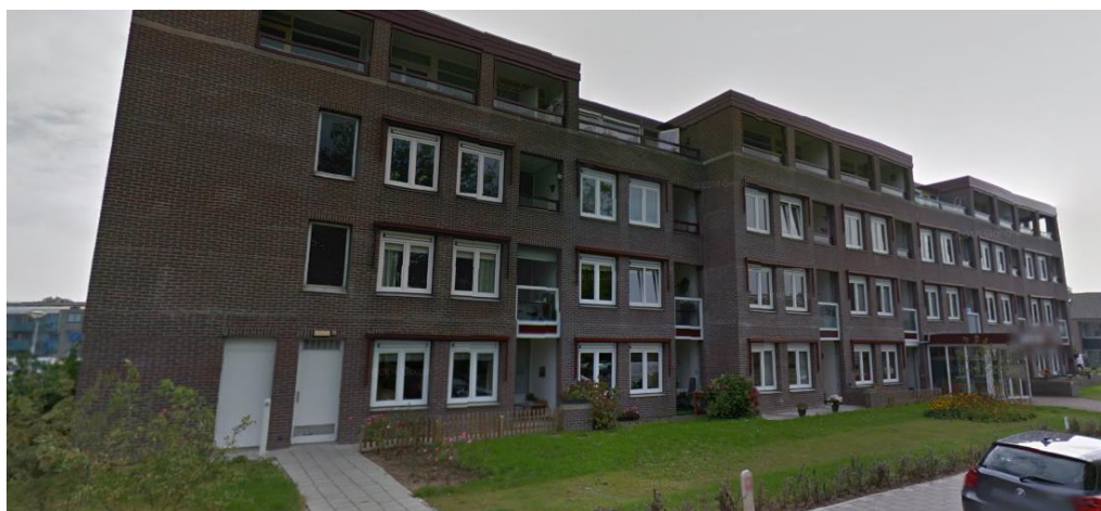
Foto bebouwing aan overzijde (oostzijde) Dirk Fockstraat
