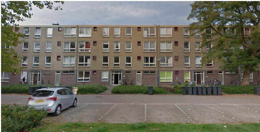
Foto bestaande situatie aan de Dirk Fockstraat (bron: Google Streetview)
