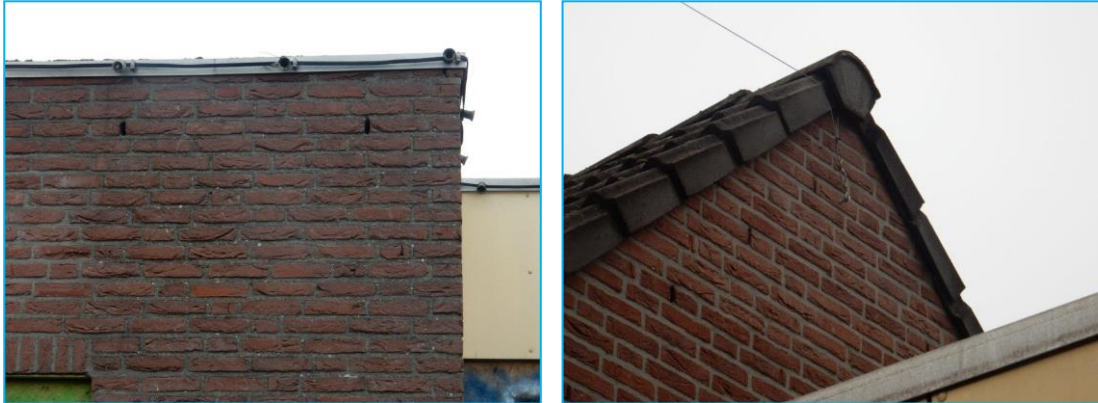
Foto's: Openingen naar potentiële verblijfplaatsen van vleermuizen.
