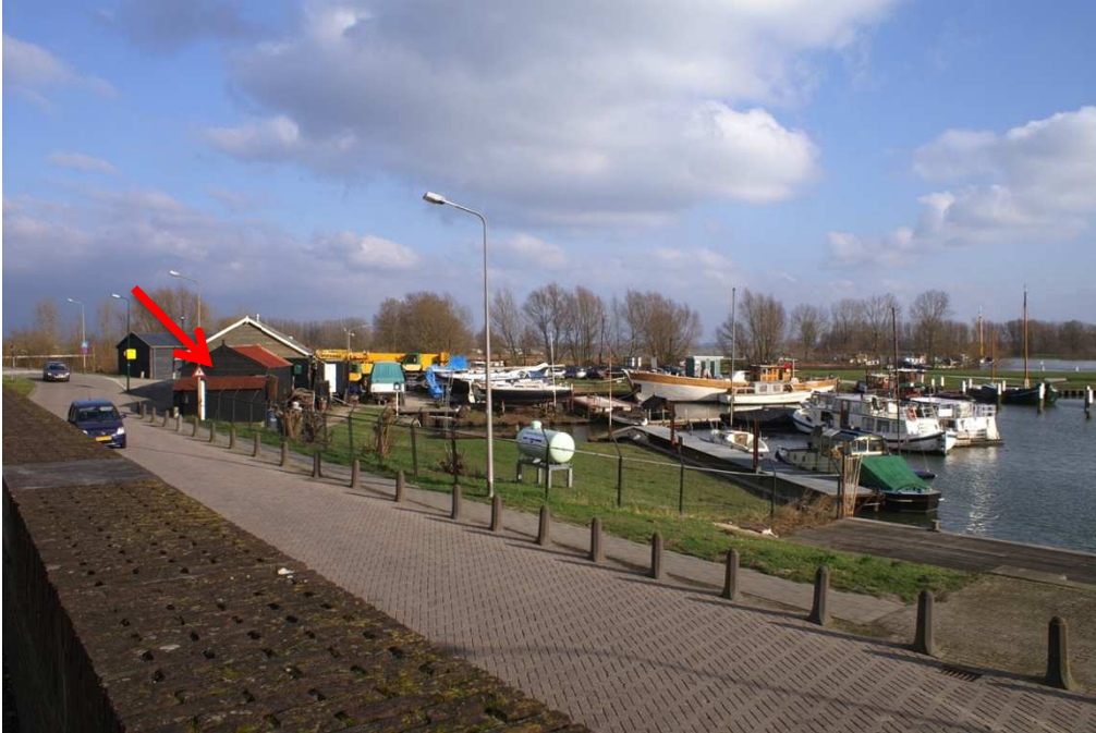
Afbeelding 4 Haven: noordelijk deel: de scheepswerf. De rode pijl wijst naar het oudste gedeelte van de gebouwen (nr. 5, hoge cultuurhistorische waarde). Op de voorgrond de Havenweg en de vernieuwde beermuur (Kijkrichting foto naar het noordoosten).
