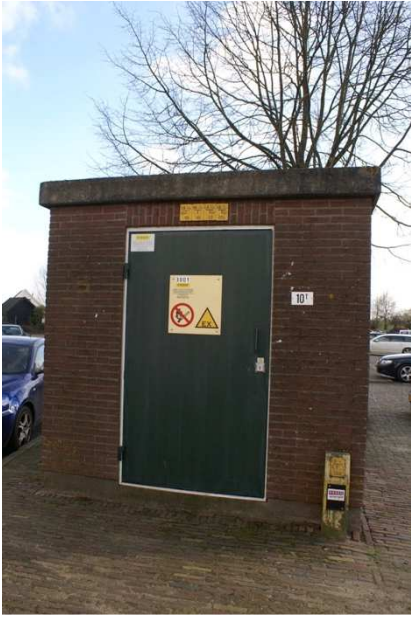
Afbeelding 3 Zeer eenvoudig transformatorhuisje uit de jaren '50: indifferente cultuurhistorische waarde
