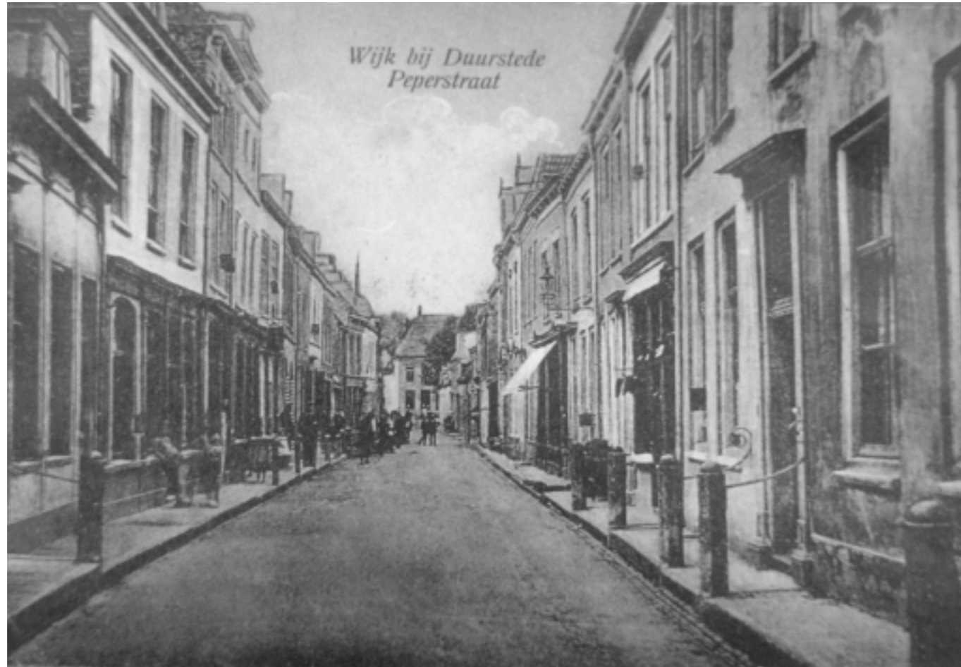
De Peperstraat rond 1900. Linksvoor een éénlaags gebouw, vervolgens een tweelaags en twee drielaags gebouwen. Fotoarchief SAKRUH.
