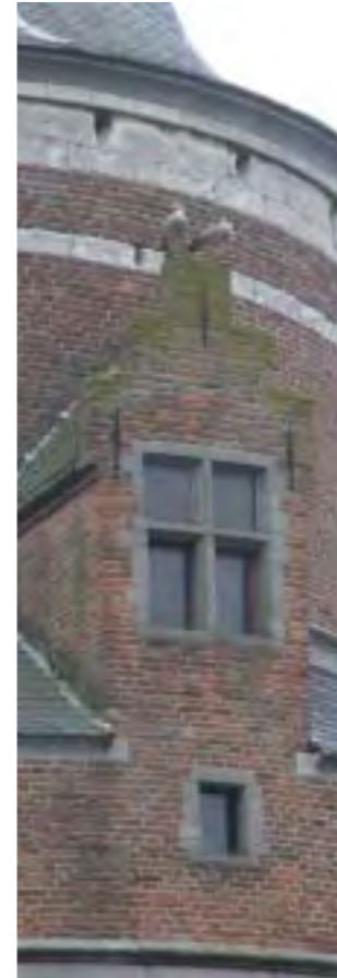
Detail oud bouwwerk met hoge geschiedkundige waarde.
